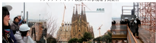
サグラダファミリア教会の工事現場写真資料
