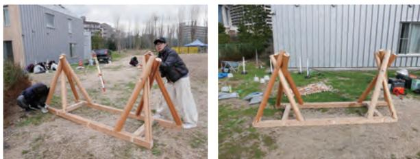
写真-42,43 木製ベンチの設置作業
