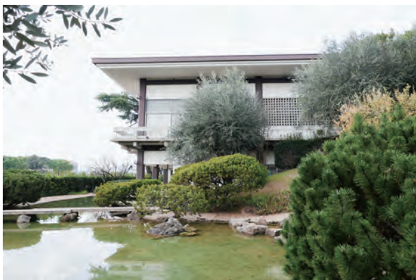
写真-18 池東側から石橋、出島、会館の姿
