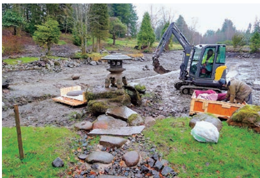
写真-5 雪見灯籠設置
