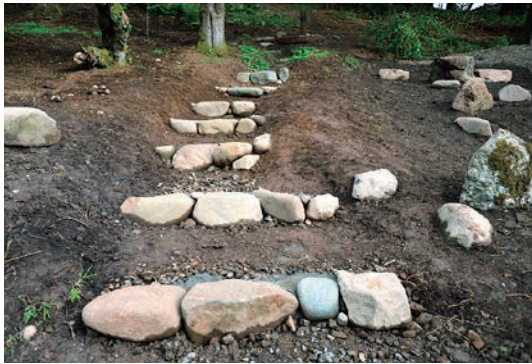
写真-35 傘亭前階段、築山石組復元写真
