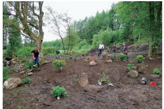
写真-20 植栽樹木植え付け作業
