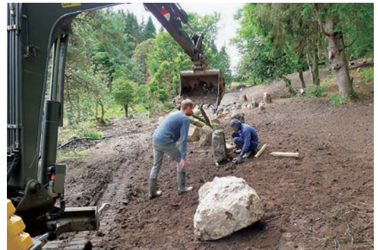
写真-28 門前石組作業
