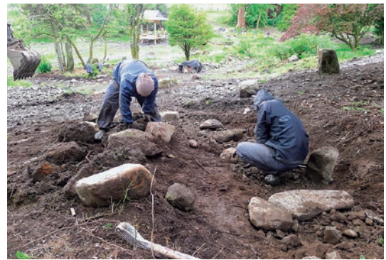
写真-24 傘亭前階段設置作業
