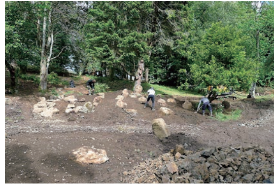
写真-27 築山整地仕上げ作業
