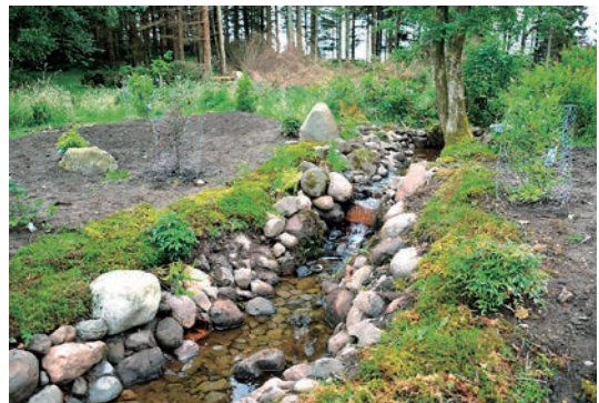
写真-33 北西側流れ石組、石積み復元写真
