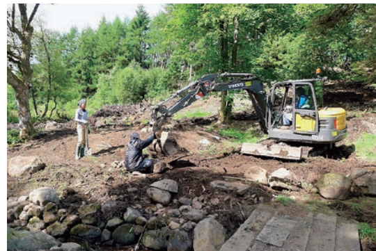
写真-17 景石設置作業
