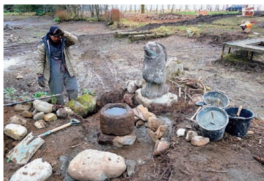
写真-7 池中央中島水鉢設置作業
