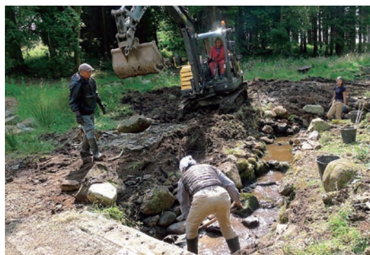
写真-13 流れ掘出し、石積み修復、景石設置作業
