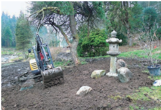
写真-9 春日灯籠周り造成、整地作業
