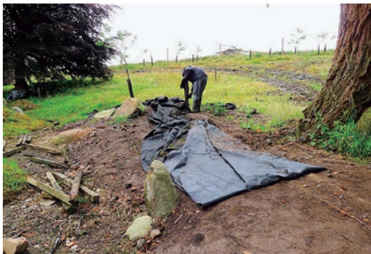
写真-30 現場片付け
