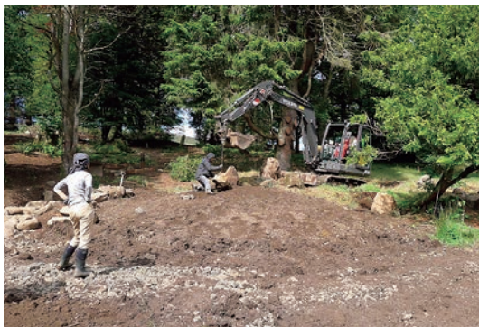
写真-26 築山石組作業
