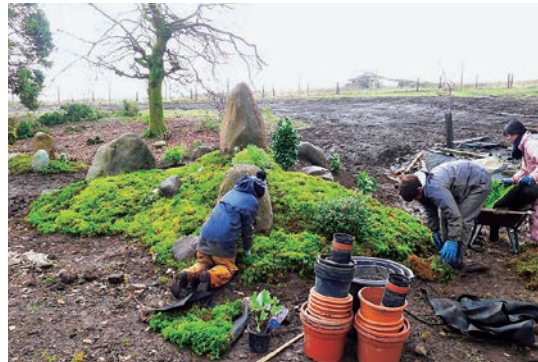
写真-10 南西側枯山水苔張り作業
