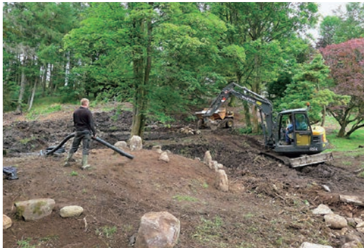
写真-18 排水ドレンパイプ設置作業
