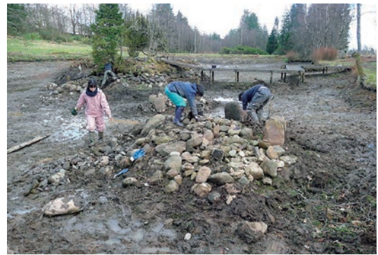
写真-3 ギャラクシーアイランド清掃、玉石敷き、景石据直し作業
