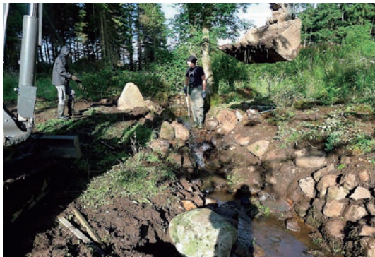
写真-15 流れ護岸石組、沢飛修復、整地作業
