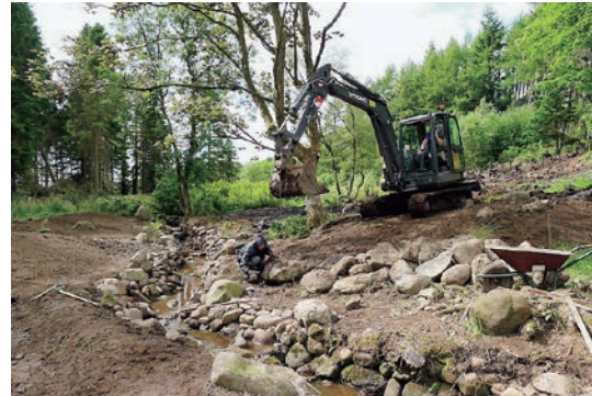
写真-16 流れ景石設置作業
