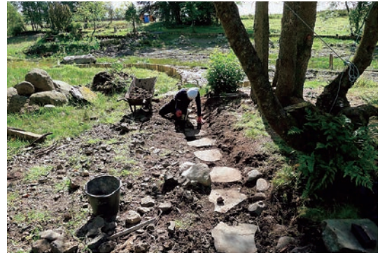
写真-23 飛石掘出し、復元作業
