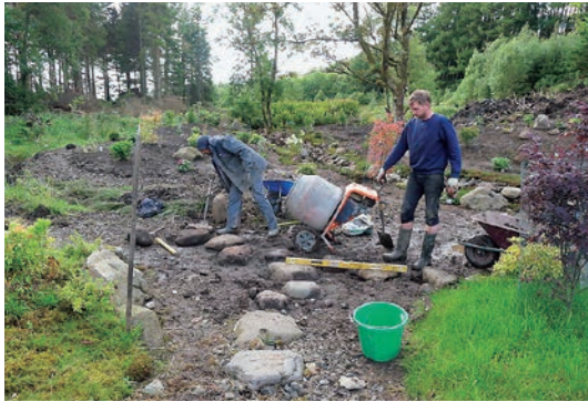
写真-25 既存飛石復元作業
