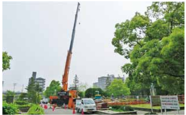
写真-14 「悠泉庭」石組工事
