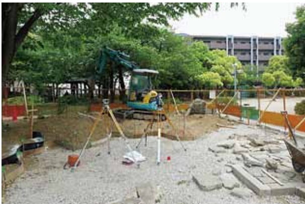
写真-18 「吉泉庭」石組工事
