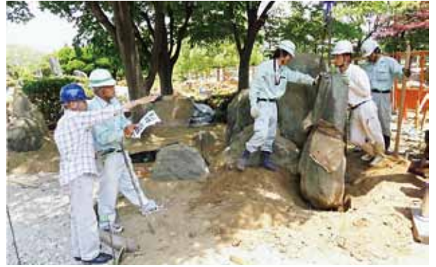
写真-19 「吉泉庭」石組工事
