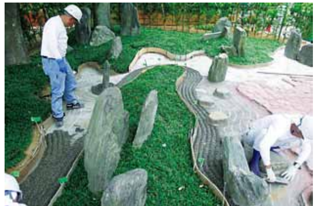
写真-21 「吉泉庭」砂紋工事
