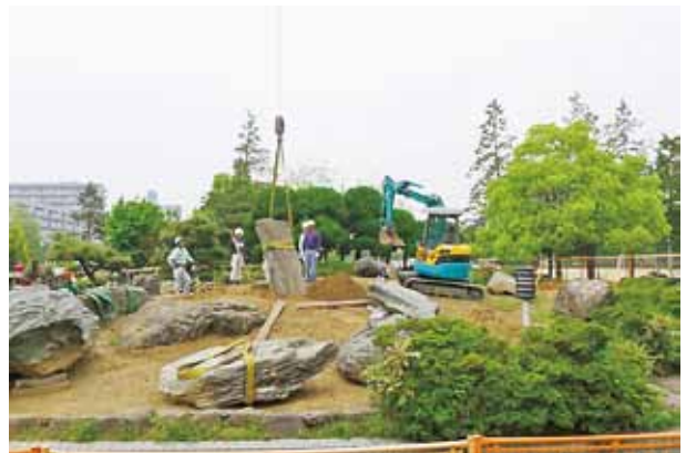
写真-15 「悠泉庭」石組工事
