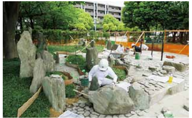
写真-20 「吉泉庭」石組工事
