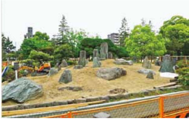
写真-16 「悠泉庭」石組工事
