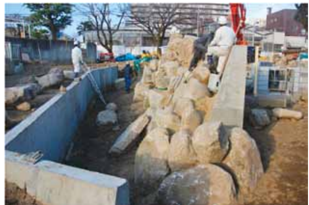
図28: カモシカの岩場。断面の構造がわかる (飯田市動物園)
