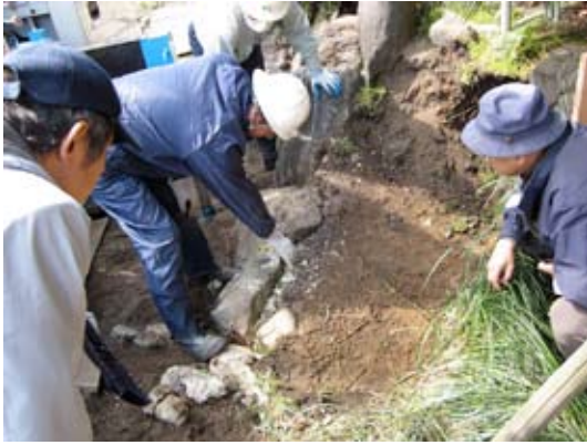
写真-5 亀尾石基礎
