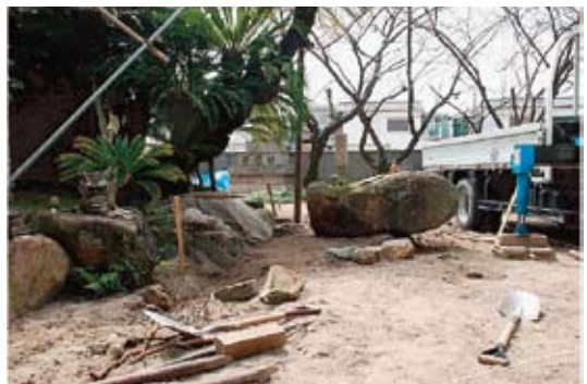
写真-10 亀頭石設置
