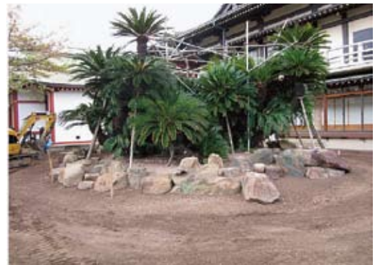
写真-13 亀石組拡張整備完了
