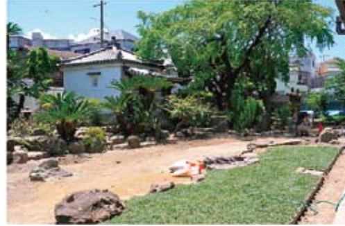
写真-31 植栽工事
