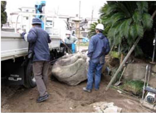
写真-6 亀尾石設置
