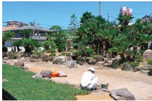
写真-32 植栽工事
