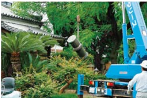
写真-21 灯籠移設
