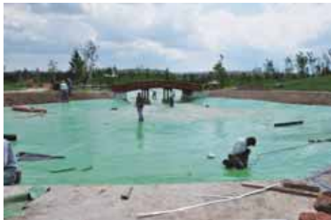
写真-28 池防水工事
