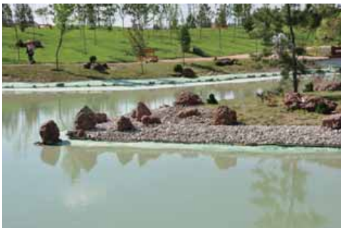
写真-33 池仕上げ工事
