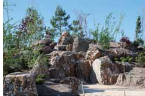
写真-26 滝植栽工事
