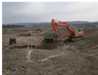
写真-19 滝造成工事
