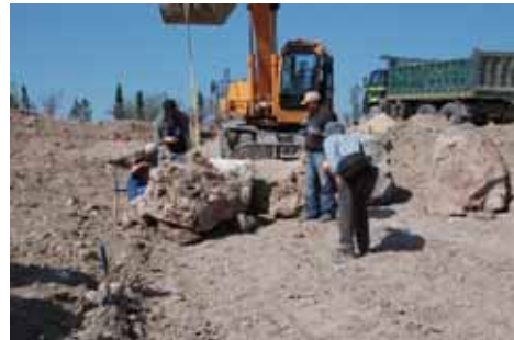
写真-27 流れ石組工事
