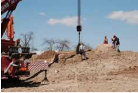
写真-24 枯山水石組 4日目
