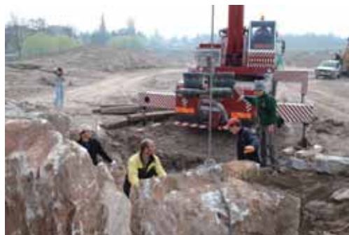
写真-22 滝石組工事施工管理
