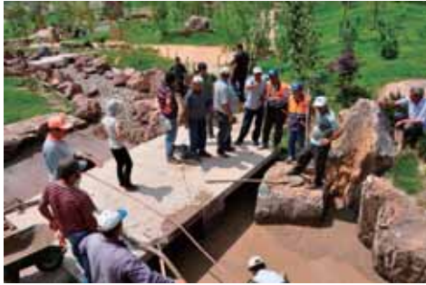
写真-31 防水工事
