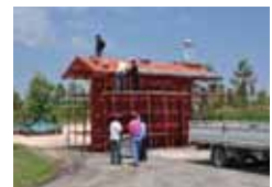
写真-35 入口門工事
