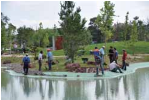
写真-32 池仕上げ工事
