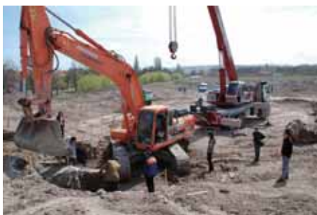
写真-21 滝石組工事施工管理 1日目
