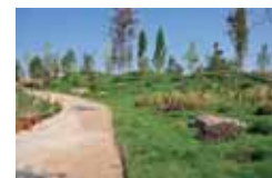
写真-42 築山完成
