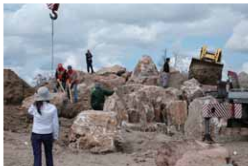
写真-23 滝石組工事施工管理
