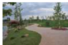
写真-43 園路完成
