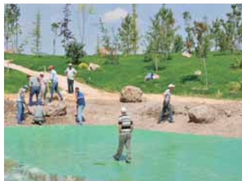
写真-30 池回り石組工事
