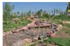
写真-41 八つ橋完成
