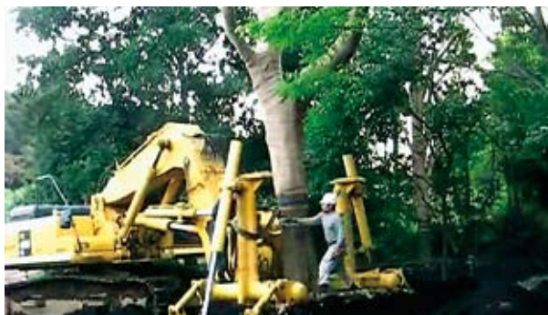
図19 主景木となる樹高23mのエノキの機械移植
