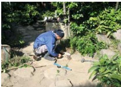
写真-30 飛石据え直し
