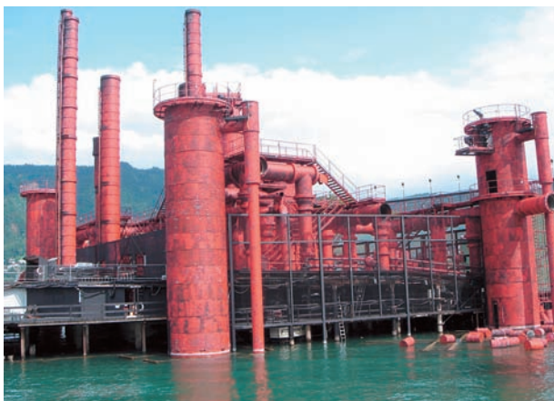
(バックステージへ向かうブリッジからのステージ裏側)
