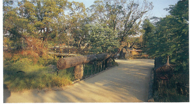
写真11 丸太造りの上橋
