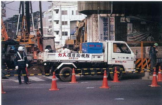
写真15 西宮市ガス復旧工事
