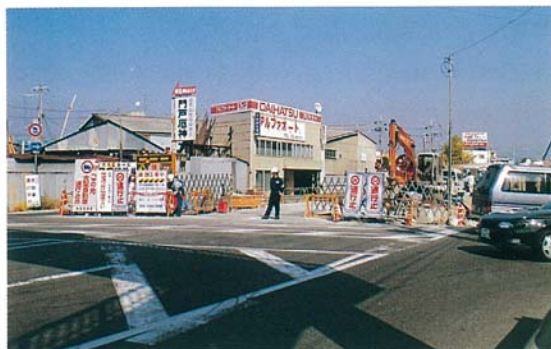
写真27 国道171号線阪急今津線高架橋復旧工事
