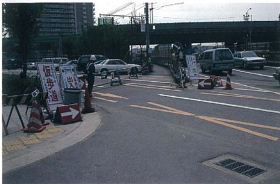
写真14 同上歩道部分
