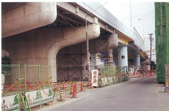
写真16 国道171号線阪急今津線高架橋復旧工事
