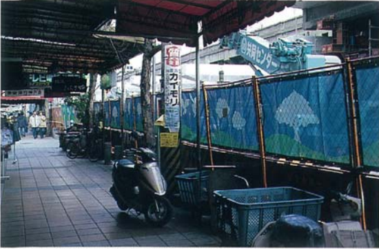
写真17 神戸市三宮元町間神戸高速鉄道復旧工事
