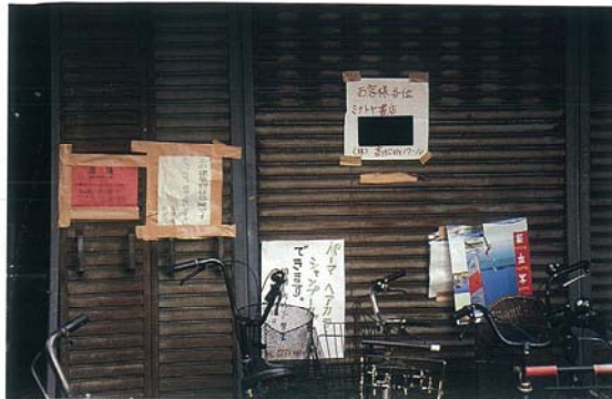
写真21 全壊商店の正面
