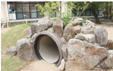
図5 丘の下にはヒューム管を配し、縁の岩で飛び降りを防ぐ
