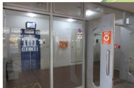
9号館1階 エレベーターホール
