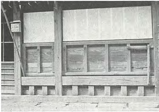
落し掛け縁台
