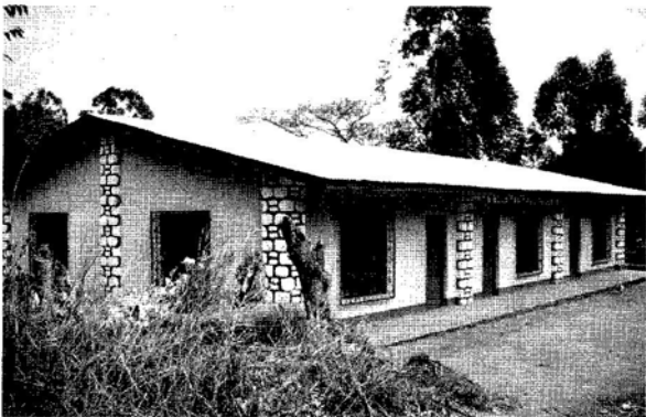
写真8 タイプ③ 壁に漆喰を塗った新しい住居
