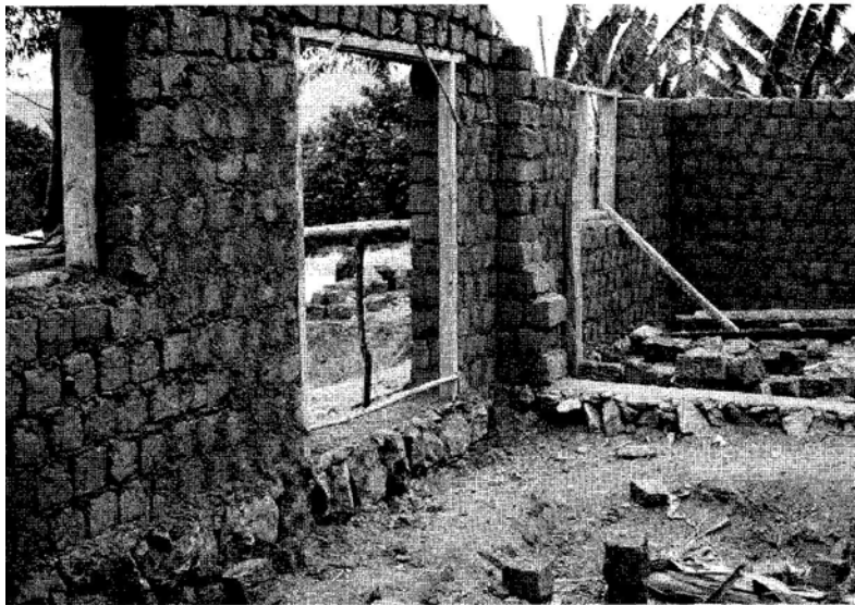
写真9 建築中の日干しレンガ壁
