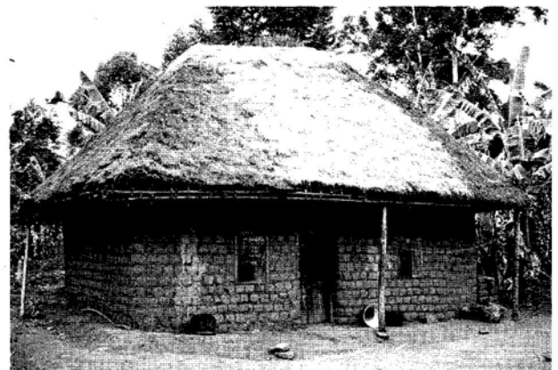
写真5 タイプ② 草ぶき屋根と日干しレンガ壁の住居
