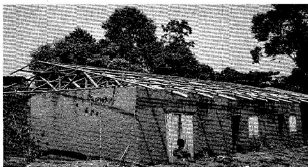
写真11 切妻型トタン屋根の小屋組
