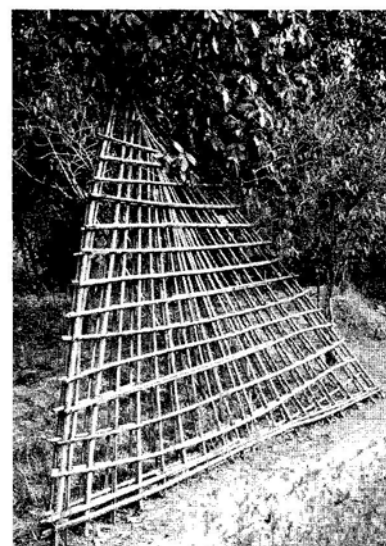
写真13 ラフィアヤシの葉柄で造った草ぶき屋根の内部構造材
