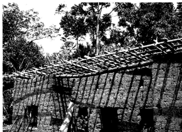
写真12 草ぶき屋根の住居の天井
