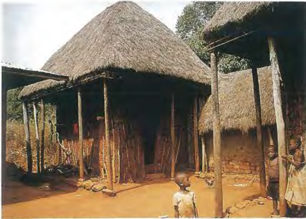
写真1 建築部材としてラフィアヤシの葉柄を用いたティカール族独特の伝統的住居。
