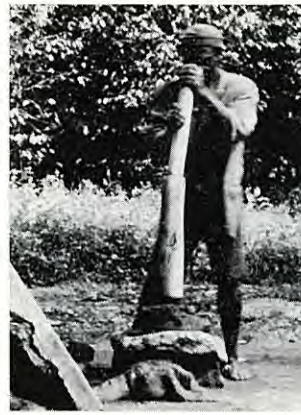
平たい石の上に2種の粘土を置き、杵でついて混練する
