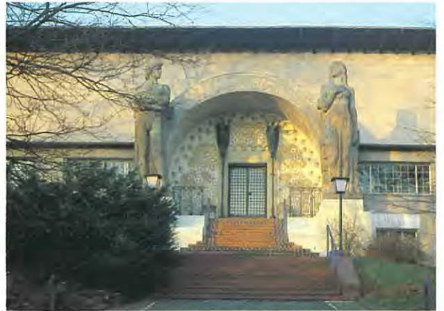
図2 エルンスト・ルートヴィヒ=ハウス(共同アトリエ棟)正面入口、1901
