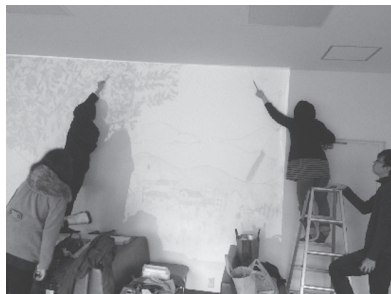
写真10) 1階・待合室の描画作業-1 下絵をプロジェクターで壁面に投影して転写する作業
